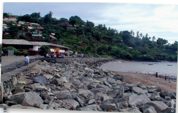
Enrochement occupant la plage sud de Sada.
